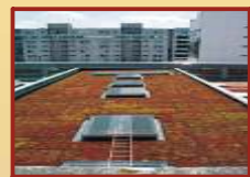
dach z Sedum
