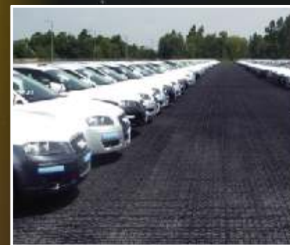
parking umocniony kratką EcoRaster; wypełnienie lawą
